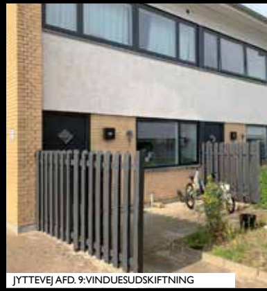
JYTTEVEJ AFD. 9: VINDUESUDSKIFTNING
