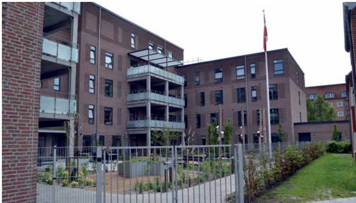
Billedet taget fra gårdsiden
