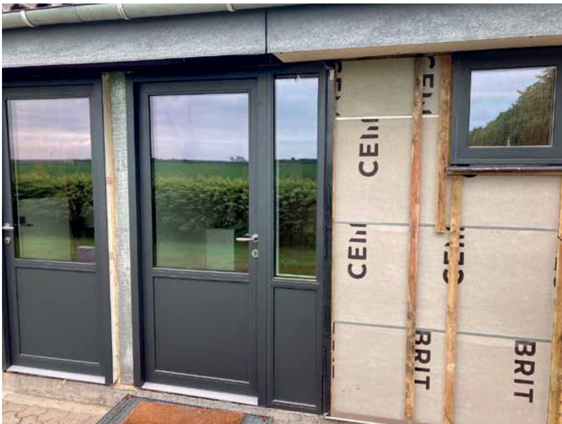
Til venstre før og til højre efter udskiftning af døre/vinduer
