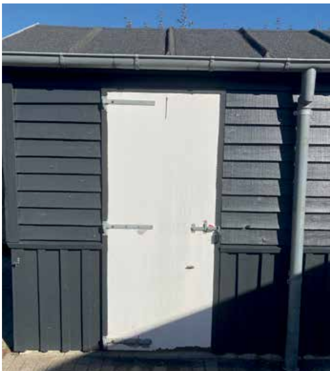
Nye døre på skurene i Lundsgårdsgade 24
