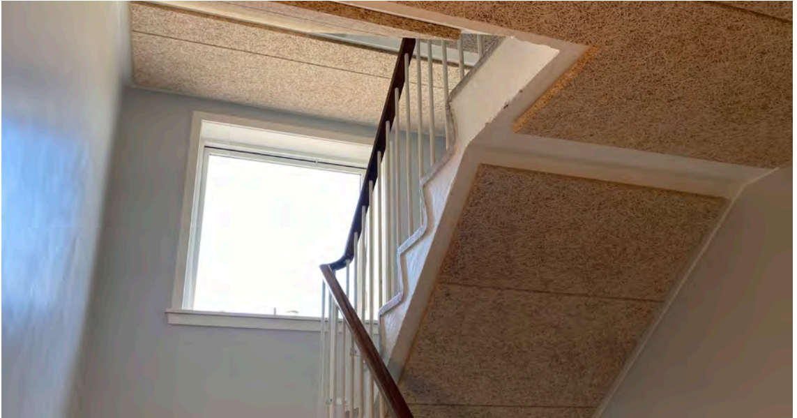
Troldekt monteret i en opgang i havrevangen.
