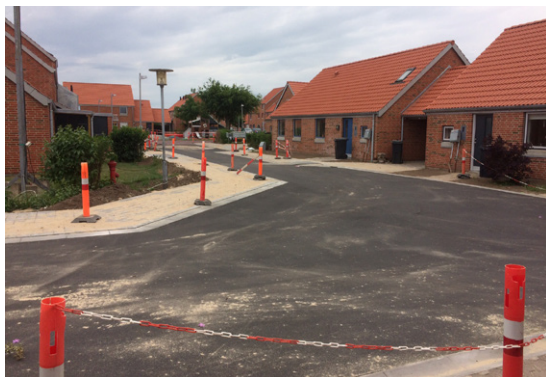
Fortove og vejbelægning genetableres
