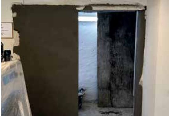
Døren til vaskeriet er flyttet
