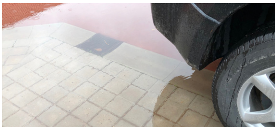
Eksemplet viser en stoppet kloak
