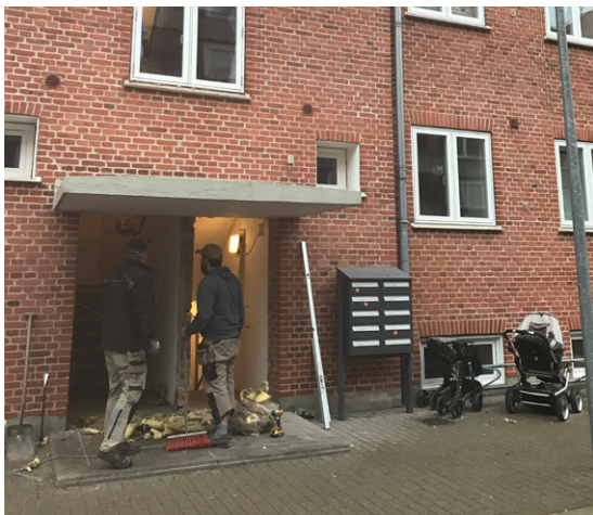
Vinduesudskiftningen er i fuld gang
