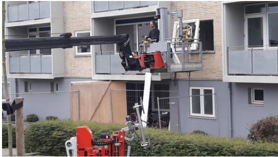
Vinduerne udskiftes ved hjælp af en lift
