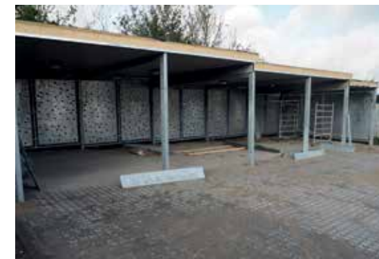
De nye carporte er udført, så de matcher miljøstationerne
