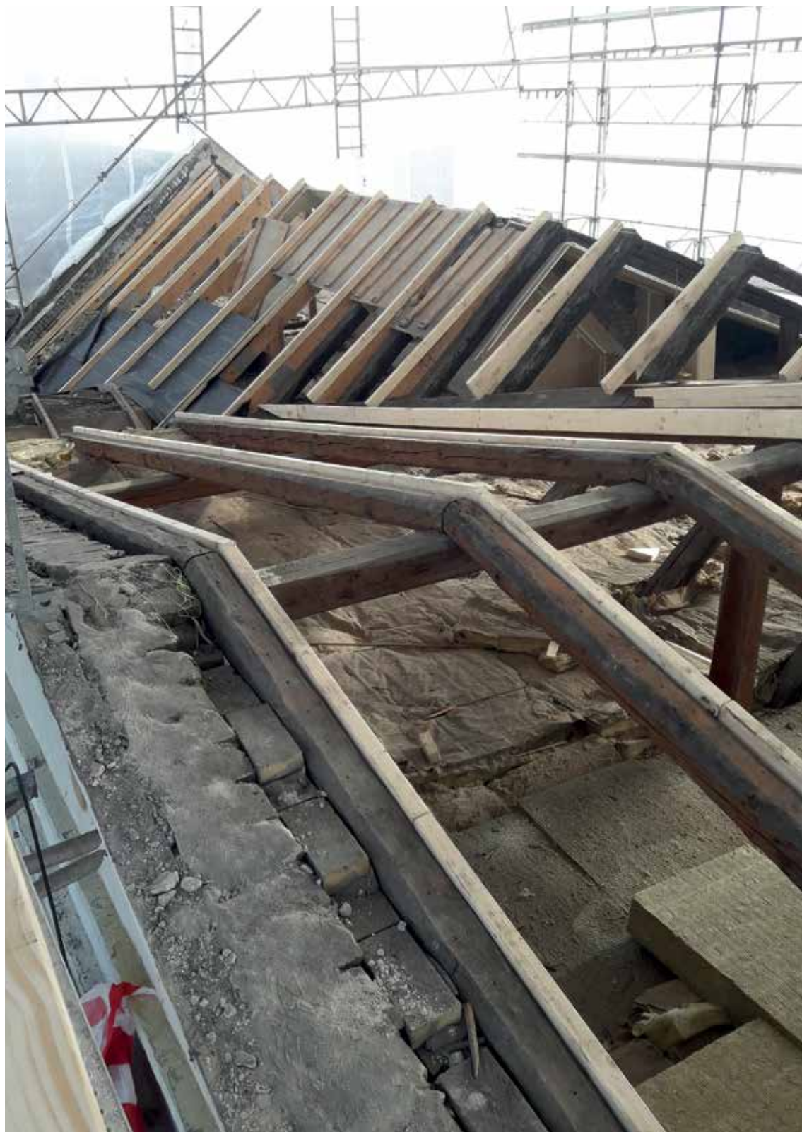
Et kig ind under inddækningen i Nyhavnsgade
