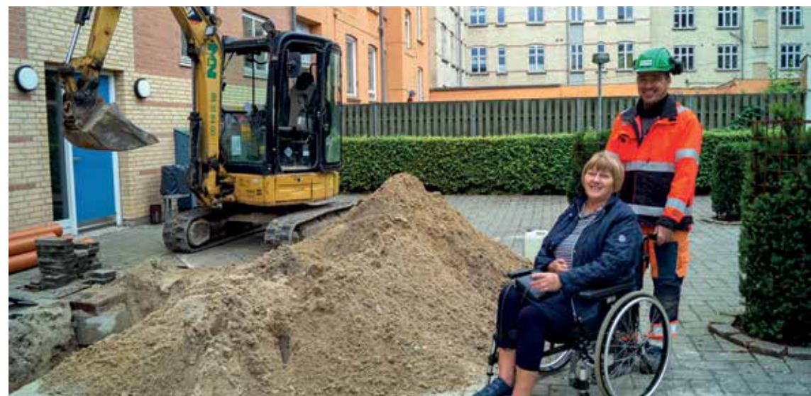
På trods af støv og støj er det vigtigt, at der er plads til både beboere og arbejdere.
